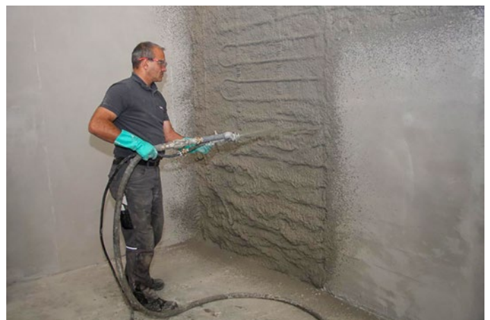
Aufbringen des Unterputzes (Systemrohrebene) mit Putzmaschine.
