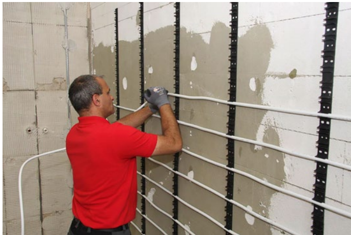
Montage der Systemrohre in Befestigungsschienen.
