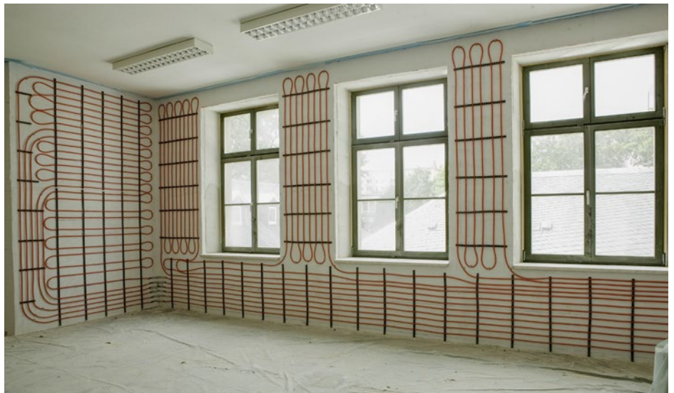
Fertig montiertes Wandheizsystem mit Systemrohren in Befestigungsschienen.
